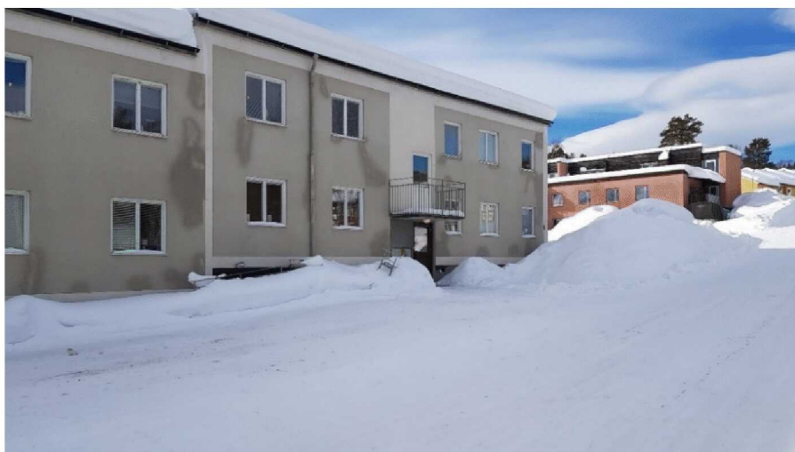
Bild 8. Hyreshus vid Centrumvägen/Ängesvägen.
