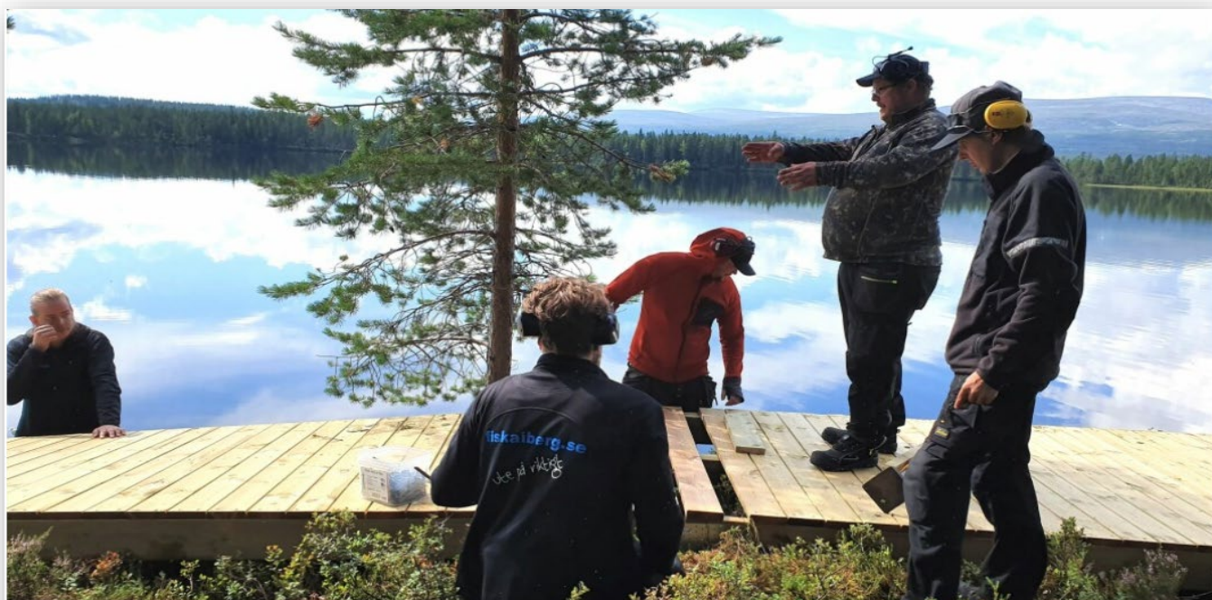
Byggnation av en bredare landgång pågår just nu i Häggsåsjön. På fotot syns Martin Liljedahl, Ludvig Hultgren, Johan Karlsson samt arbetsledarna Patrik Jonsson och Niklas Öst, alla från daglig verksamhet, Bergs kommun. Foto: Conny Elf
